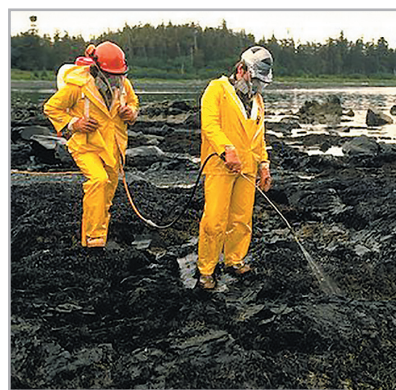
Figura 2.7. Aplicarea de îngrășăminte cu azot pe terenurile contaminate cu petrol (pentru a crește rata de biodegradare a acestora)
